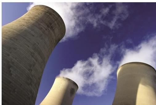
工業分野において、シリカや他のミネラルを多く含む水は、配管内にスケールを生じさせます。理由はシリカやミネラルが不溶性塩として配管内に沈殿してしまうためです。ボイラーやクーリングタワーでは、水を高温で蒸発させますが、その水に溶解したミネラルが含まれていると、スケールが急速に生じます。
